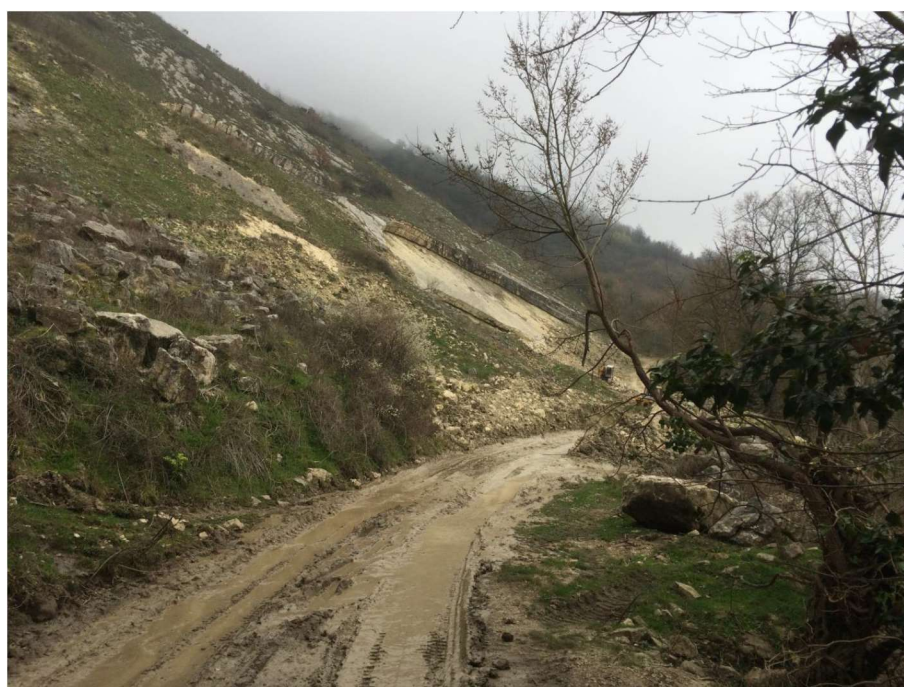
Frana con distacco blocchi e conseguente rottura di due condotte dell'acquedotto comunale. Aggravamento di situazioni preesistenti. Comune di Panni.
