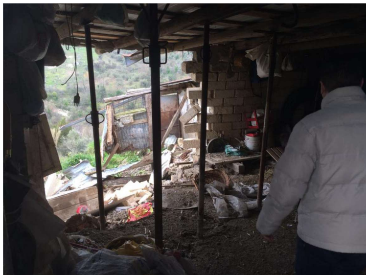
Frana a ridosso di zone abitate. Aggravamento rispetto ad eventi Ottobre 2015 con parziale crollo di un magazzino. Comune di Bovino località Pianello Via A. Moro.
