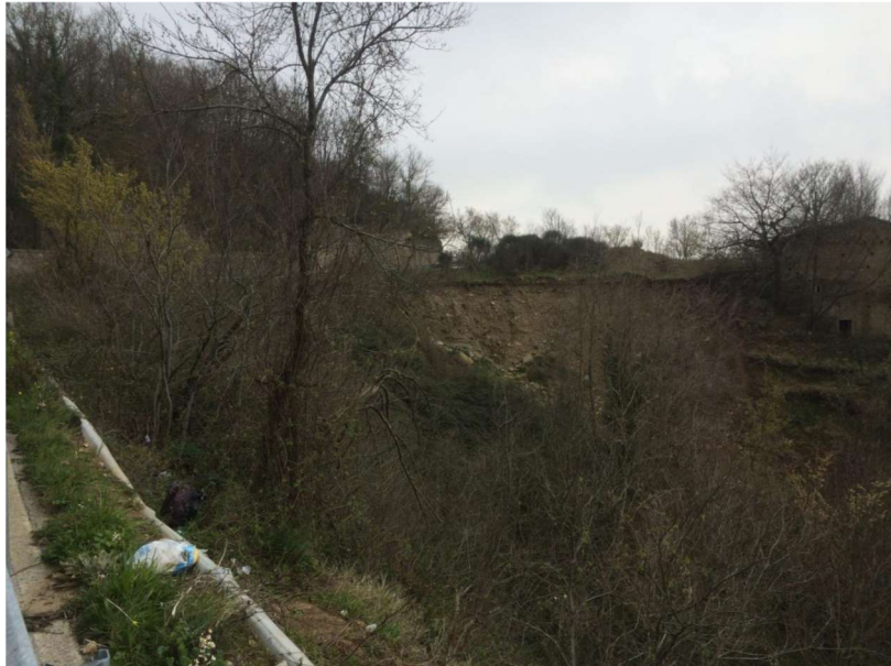
SP121 di collegamento Panni- stazione. Frana a ridosso della sede stradale.
