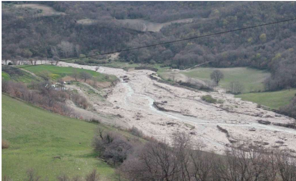
Torrente Celone. Accumulo materiale lapideo lungo tutto il corso d'acqua al limite col piano campagna e danneggiamenti opere idrauliche (briglie).
