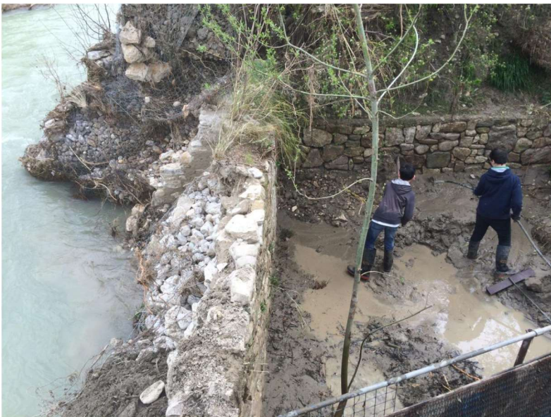
Torrente Cervaro. Mulino sul Ponte Romano. Aggravamento caduta gabbionate Edificio danneggiato - nuovi danni determinati dall'evento.
